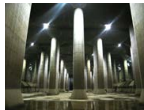
G-Cans, tunnel anti-inondation de la zone métropolitaine extérieure de Tokyo
